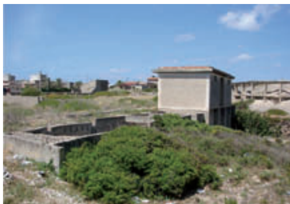
Ruderi vecchio impianto di depurazione
